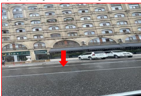
Gülərə Qədərbəyova küçəsi (nişanlanma xətti çəkilib, lakin xətti kəsib parklanma etmək üçün qırıq-qırıq xətt yoxdur)
